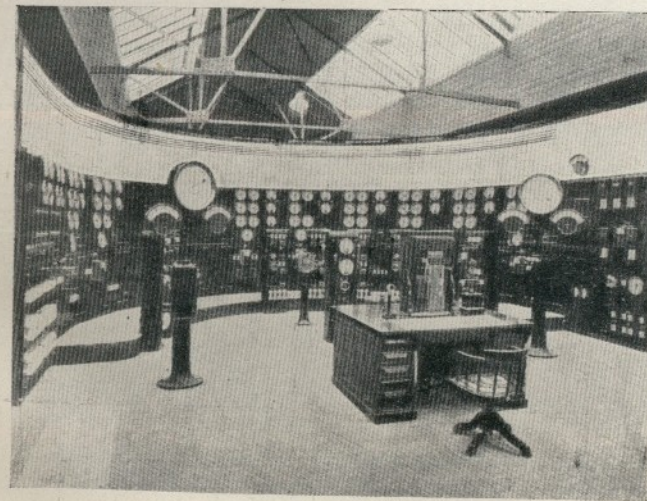
B. NASTAWNIA ELEKTROWNI TRAMWAJOWEJ w Liverpoolu
