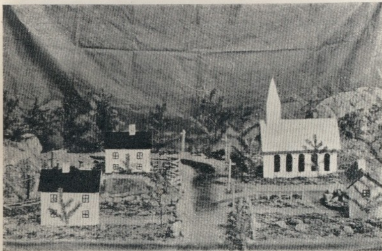
A. MINIATUROWE MIASTECZKO DO DOŚWIADCZEŃ Z SZTUCZNYMI BŁYSKAWICAMI Zawiera on w odpowiedniej skali nawet elektryczną linię przesyłową i tor kolejowy
